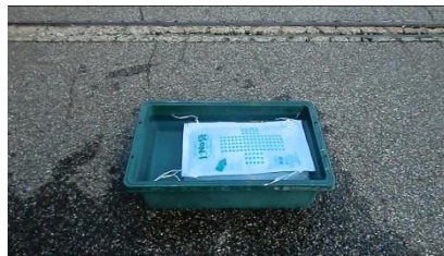
土No袋に吸水させます。土No袋をもみほぐすようにすると吸水が早まります。
